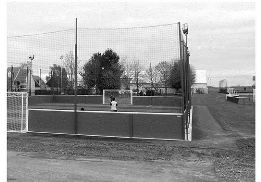
Tout autour du terrain synthétique, une allée goudronnée a été créée afin de protéger la surface et d'éviter d'éventuels dépôts de terre.
