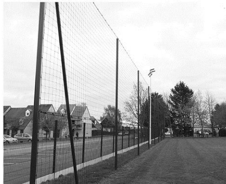
Derrière les terrains d'entraînement, des filets pare-balls ont été installés pour protéger les habitations des rues du Stade et Savigné-Lévêque.
