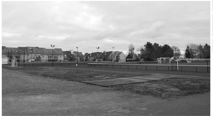
Face à l'ancien parking, un second parking est en cours de construction qui devra doubler le nombre de places disponibles dans l'enceinte du stade. Un accès véhicule pompier permettra également de parvenir directement jusqu'à l'entrée des tribunes en cas de besoin.
