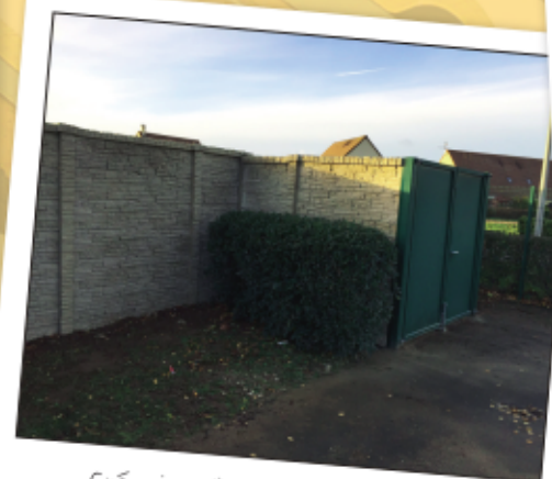
Création d'un nouveau mur beaucoup plus décoratif pour le cimetière
