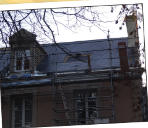
Une Refection de la toiture de la mairie
