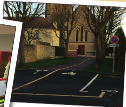
Des marquages au sol pour répondre aux normes PMR.
