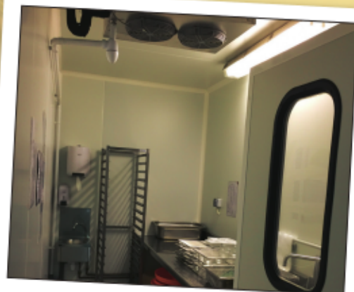
Mise en place d'une chambre de préparation réfrigérée
